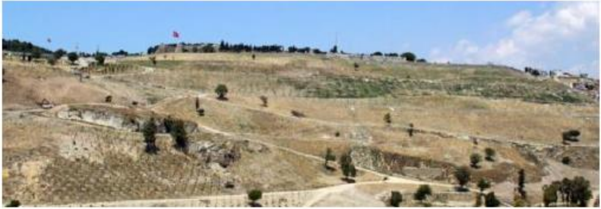
Şekil 30: Yıkım öncesi ve sonrası Kadifekale
