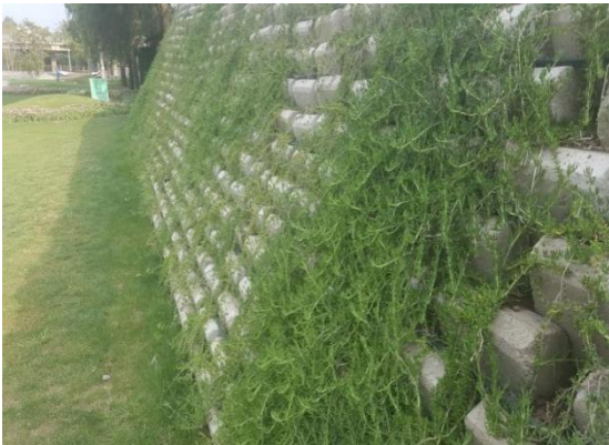
Şekil 49 : Şev taşı uygulaması
